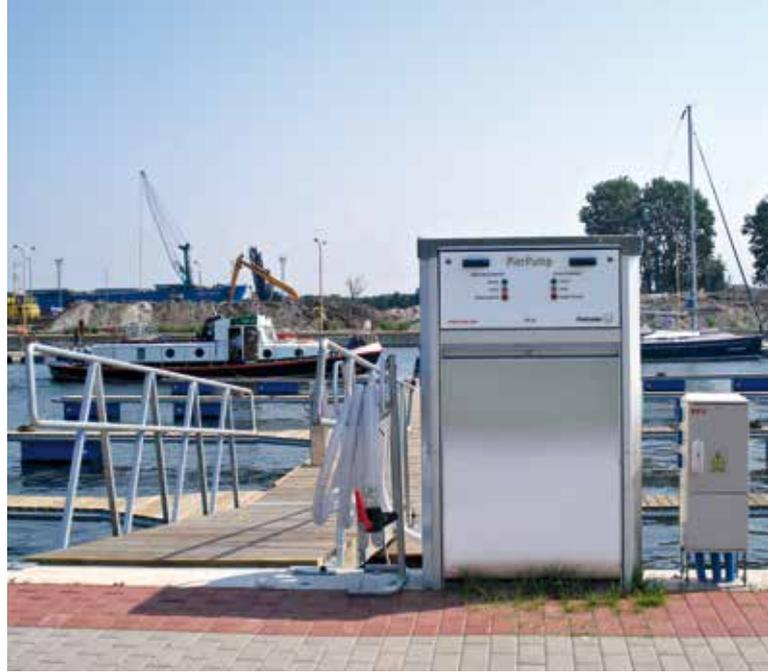
**Technologie muss einfach zu handhaben und immer zugänglich sein. Herzstück unserer Entsorgungssysteme ist die Original-Drehkolbenpumpe von Vogelsang: eine selbstansaugende Verdrängerpumpe speziell für dickflüssige Medien und mit Fremdkörpern verschmutzte Flüssigkeiten. Das Medium wird direkt von den hochrobusten, elastomerbeschichteten Drehkolben angesaugt und in die Kanalisation gepumpt.**
