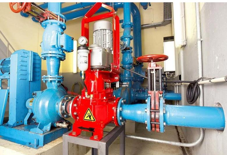
**Schmutzwasserzerkleinerer XRipper XRP136-140Q**
