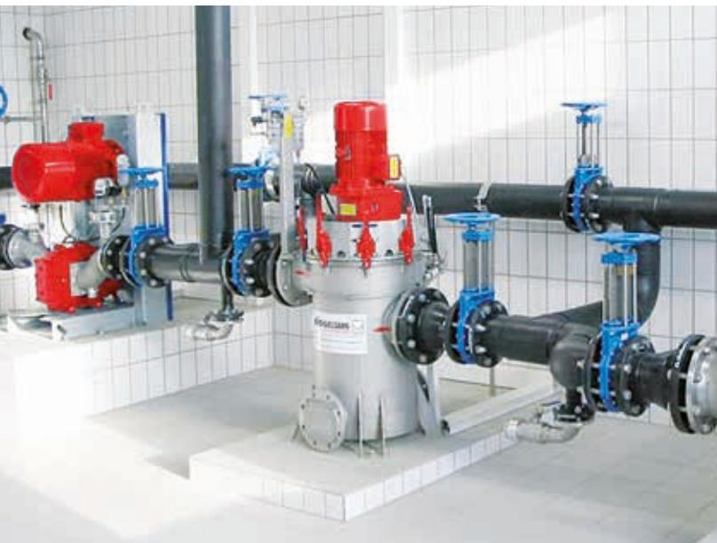
Tandis que le flux du liquide traverse en continu le RotaCut, les matériaux lourds comme les pierres ou les pièces métalliques sont séparés par la gravité, tandis que les fibres et les matières solides sont dilacérées et le fluide homogénéisé.
