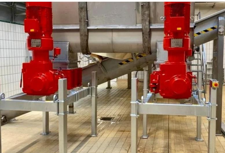
Die installierte Leistung ist somit geringer und die Verbrauchsdaten nach der Inbetriebnahme sind sehr interessant: Mit der vorherigen Lösung lag der tägliche Energieverbrauch des Zerkleinerungsraums bei etwa 650 kWh, während der Energieverbrauch jetzt auf 250 kWh gesenkt wurde.
