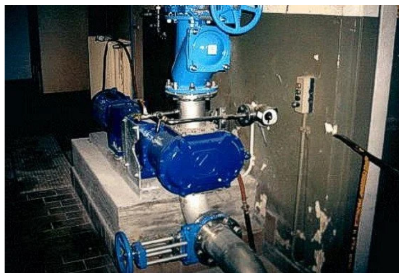
Vogelsang Drehkolbenpumpe VX186-260Q
