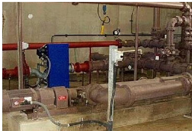
Čerpadlo s rotačními písty VX136-70Q od společnosti Vogelsang
