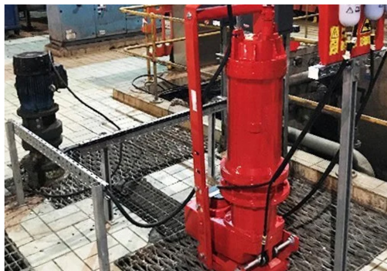
Trituradora de aguas residuales Vogelsang XRipper XRC-SIK
