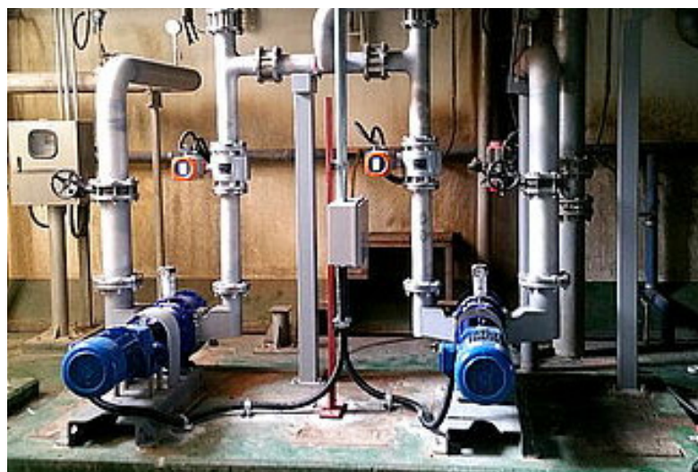
使用旋转凸轮泵进行 MBR 过滤: 只需一台泵, 管道和阀门更少
