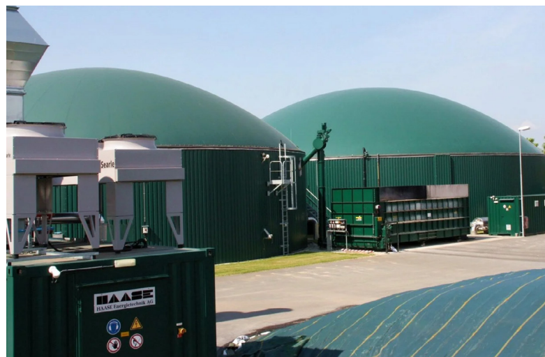
Impianto biogas di Bioenergie BAGUS GmbH & Co. KG
