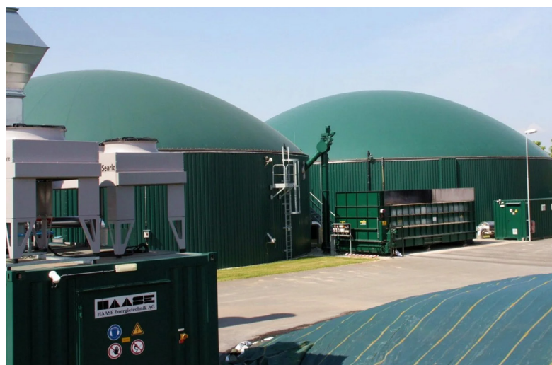
Bioenergie BAGUS GmbH & Co. KG沼气厂
