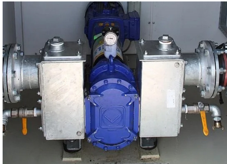
福格申带连接箱的转子泵
