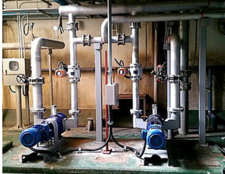
Filtration MBR avec pompe à lobes rotatifs : une seule pompe, moins de tuyauterie et de vannes
