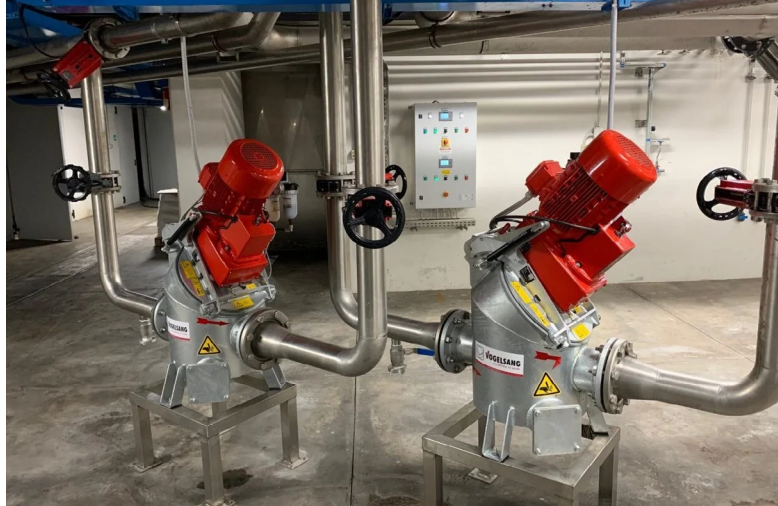
Inline maceratorer med ACCplus, der separerer tunge partikler og sikrer homogent slam før afvandning
