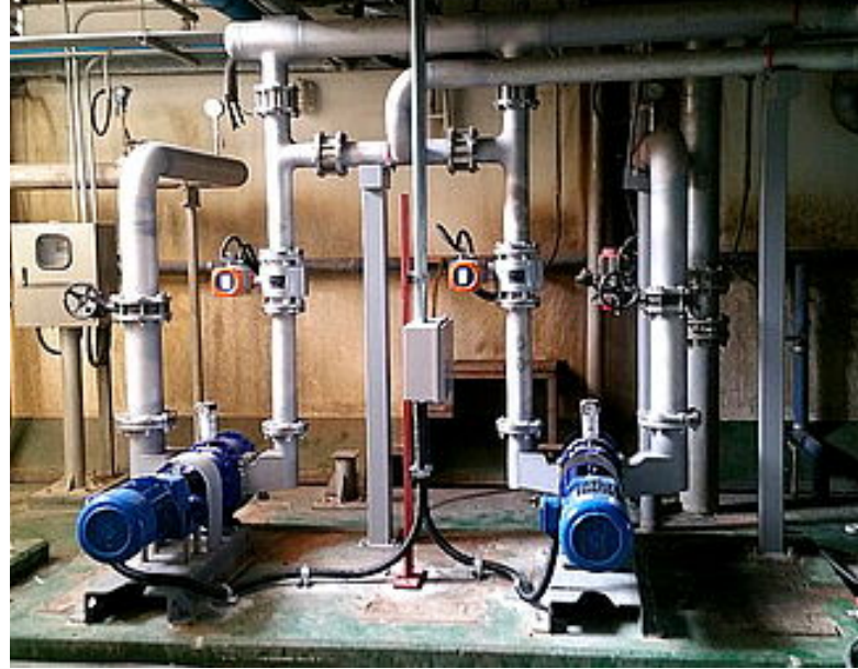
Kompakt installation med reversibel drift, der håndterer både filtrering og membranspoling uden ekstra pumper og ventiler
