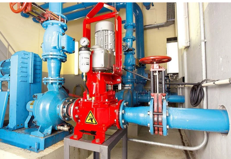
Inline-installation, der reducerer vådservietter og hygiejneprodukter før pumpen og sikrer stabil drift uden tilstopning
