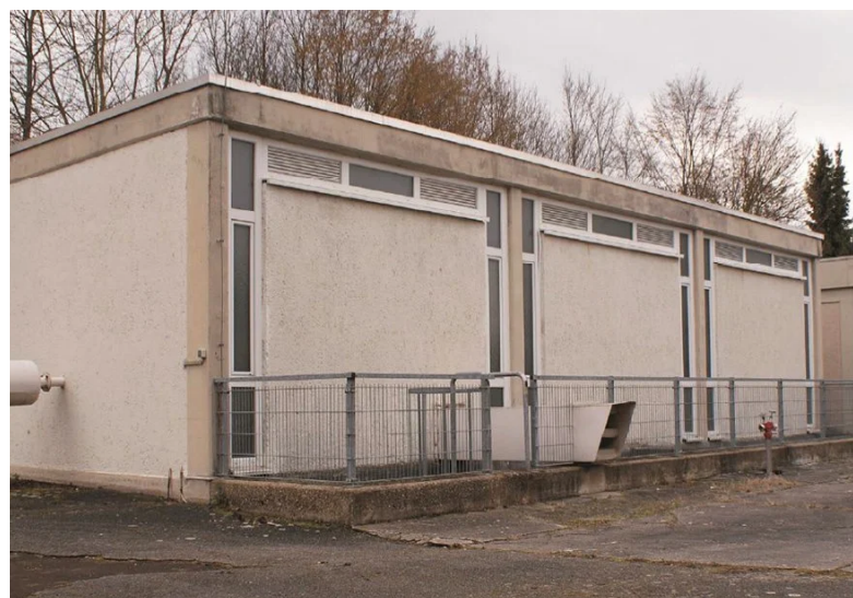
Kommunal pumpestation med tre centrifugalpumper, som løfter spildevandet til terrænniveau før videre transport ved gravitation
