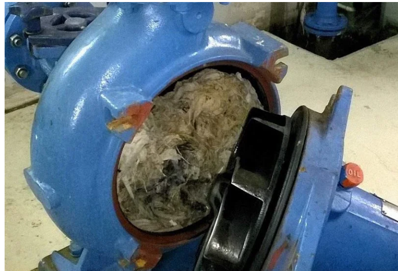
Eksempel på tilstopning forårsaget af vådservietter, som kræver manuel rensning og medfører driftsstop
