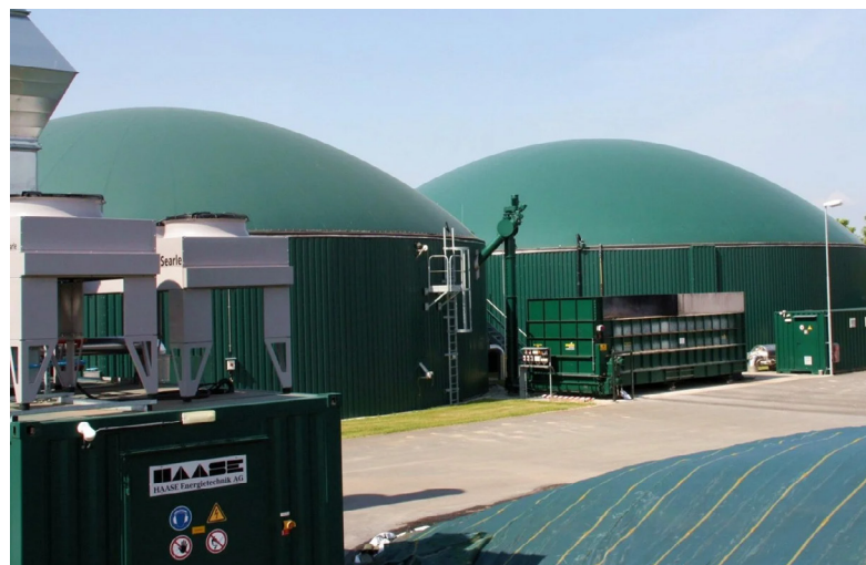
Biogas plant of Bioenergie BAGUS GmbH & Co. KG
