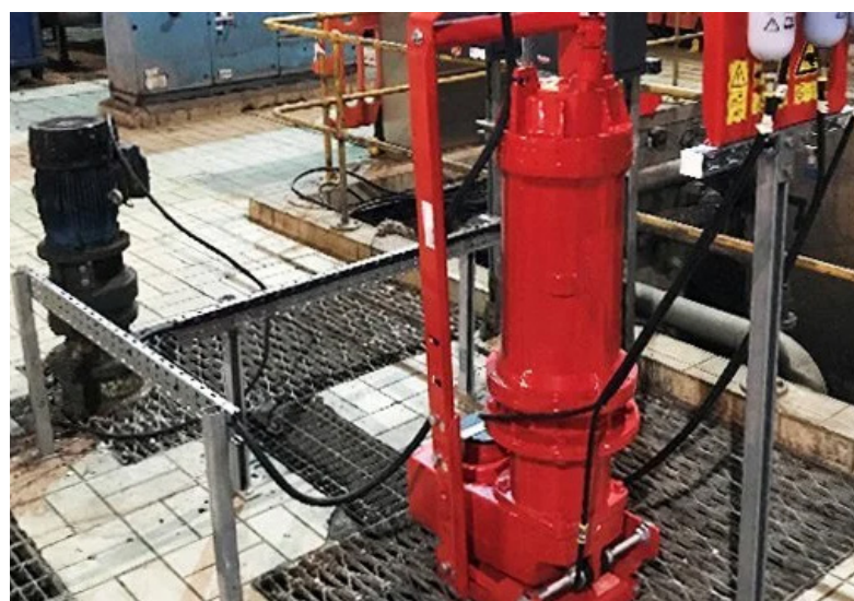
Wastewater grinder Vogelsang XRipper XRC-SIK
