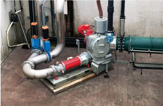
**Bild 1:** Der universelle Feststoffdosierer PreMix maischt unterschiedliche Substrate zu einer homogenen Biosuspension an.
