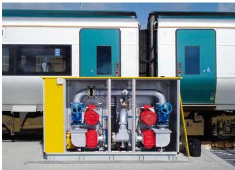
**Kompaktes Innenleben:** Pumptechnologie vom Marktführer sichert schnell und zuverlässig das Entsorgen von Abwässern aus Bordtoiletten.
