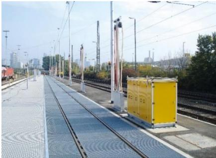
**Bild 1:** Die TUnit MP für die Abwasserentsorgung und Trinkwasserversorgung von Zügen wird als Mehrplatzlösung installiert.
