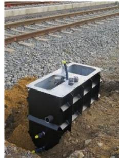
**Bild 2:** Die vorgefertigte Fundamentkonsole vereinfacht den Einbau der TUnit.
