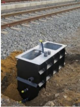
Bild 3: Die Fundamentkonsole vereinfacht den Einbau der TUnit.
