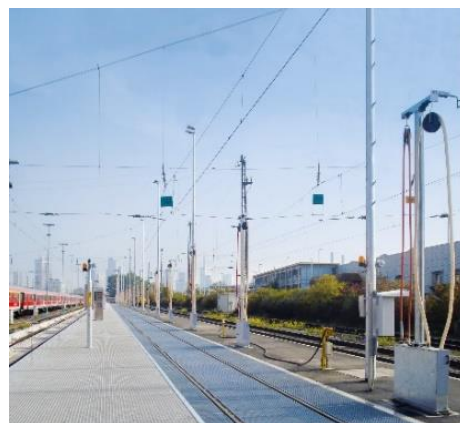
Bild 2: Die TUnit MP sorgt für die hygienische und servicefreundliche Abwasserentsorgung und Trinkwasserversorgung von Zügen.
