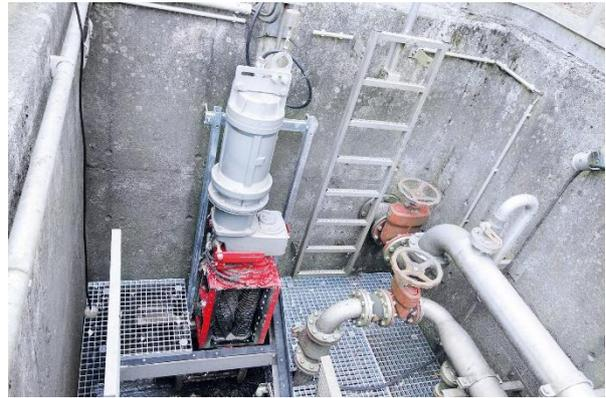
**Bild 4:** Der X-Ripper XRC mit SIK direkt vor einem Einlauf montiert
